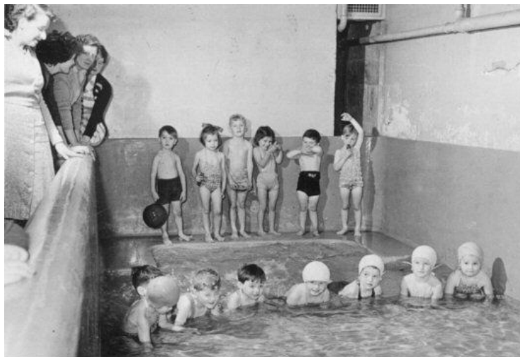
La piscina cubierta del centro Peckham (abajo: vaso de piscina para aprendizaje).
