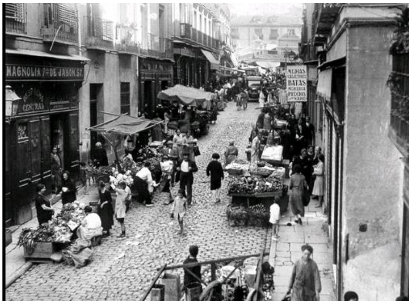
Mercadillo en la Corredera Baja de San Pablo, hacia 1900, en las proximidades del Mercado de San Ildefonso, cuya fachada se distingue al fondo de la calle. Madrid. http://urbancidades.wordpress.com/2008/07/02/fotos-de-mercados-antiguos-de-madrid-iii/
